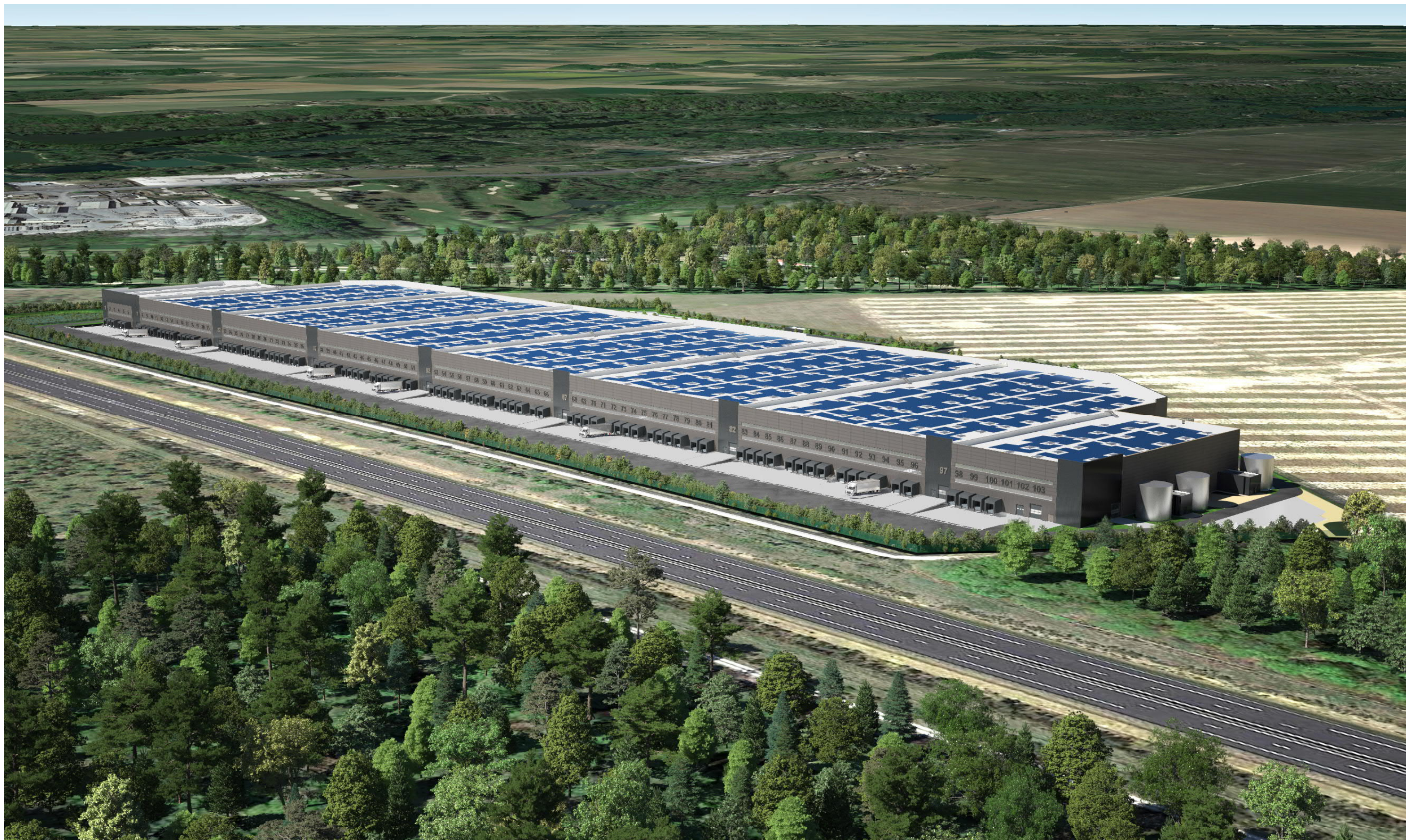
1- VUE AERIEENNE DEPUIS LE SUD-EST.
